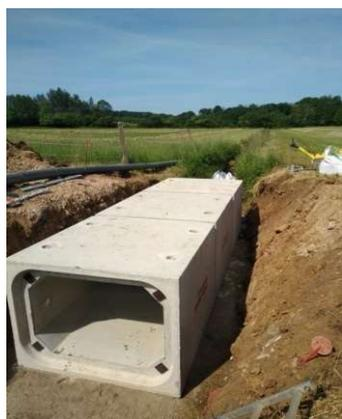
**MAI 2022:** Remplacement du passage sous route ch. du Crémoulot. La buse ronde de diamètre 900 est remplacée par une buse rectangulaire de 1200. Augmentation de 50% du débit d'eau.
