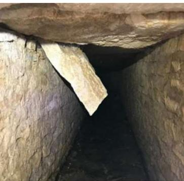
**A venir: Avril 2025:** intervention dans les réseaux souterrains afin de réparer et retirer tous les éléments bloquants au bon écoulement des eaux pluviales. Vérification des branchements pénétrants.
