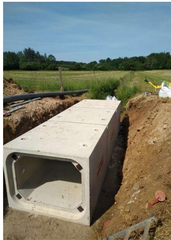
La première phase de travaux est maintenant terminée avec le redimensionnement de la buse traversant le Ch. du Crémoulot. La buse rectangulaire de 1200 est maintenant en place. Le débit d'évacuation est maintenant doublé, permettant déjà un meilleur écoulement en cas de forts orages. C'est l'entreprise CADOUX qui a réalisé ces travaux pour un montant de 9 850 € HT dont 30% de subventions soit 2 955 € qui nous seront remboursés.
