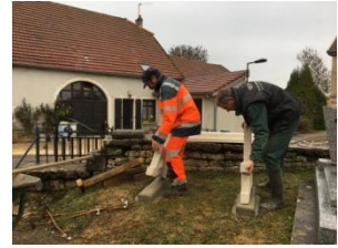
Pose de 2 bancs dans le cimetière
